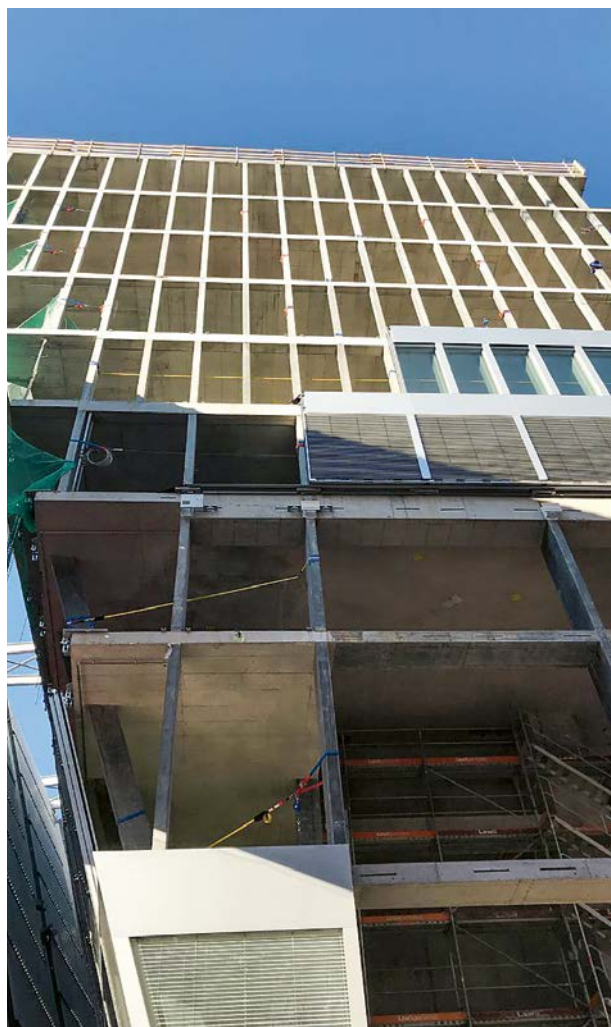
Der Stützenraster verändert sich über die Gebäudehöhe.
