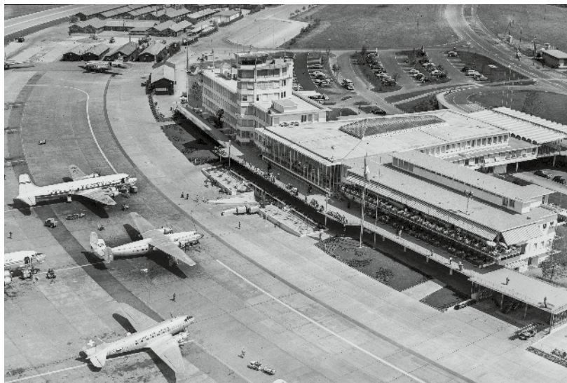
Der Flughafen der Gebr. Oeschger aus dem Jahr 1953. Er war das erste permanente Passagierabfertigungsgebäude und löste das dahinter sichtbare Barackendorf ab.
